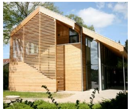
Abbildung 24 Beispiel Fassade Bsp. für imagestiftende Fassade, als „Adresse“ für eine Ortsmitte (Stoy Architekten, Erlösergemeinde Henstedt)
